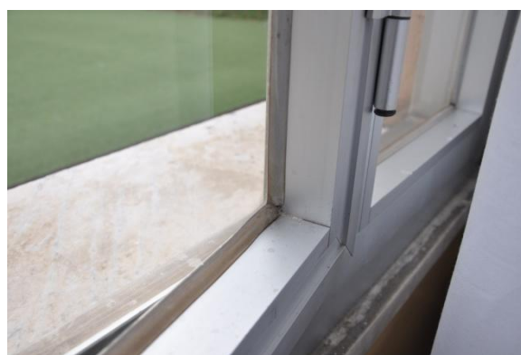
Figura 4.4 - Particolare dei serramenti
