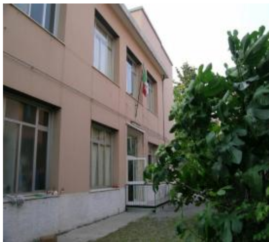
Figura 1.1 - Vista della facciata con l'ingresso esposta ad Ovest
