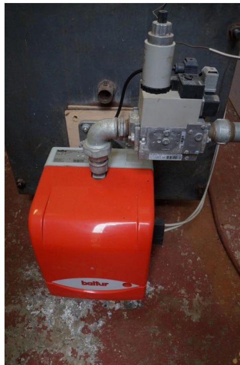
Figura 4.12 - Particolare del generatore di calore
