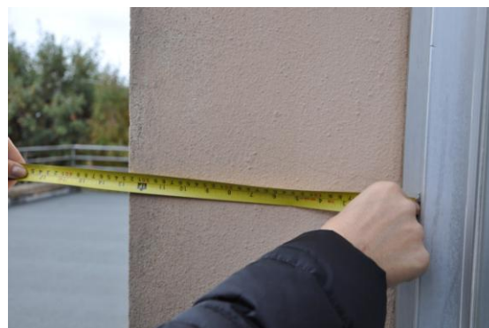
Figura 4.1 - Particolare della muratura esterna
