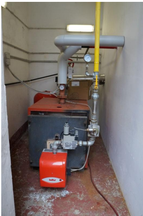
Figura 4.11 - Generatore di calore
