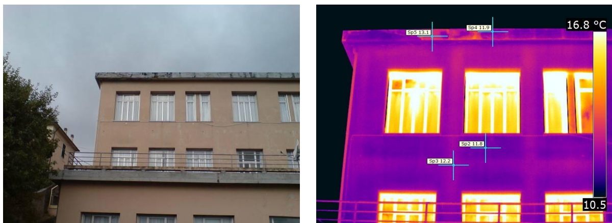
Figura 4.3 – Rilievo termografico della parete del fronte est
