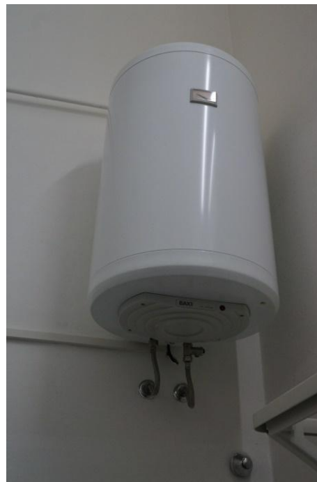
Figura 4.13 - Particolare di un boiler elettrico per la produzione di acqua calda sanitaria
