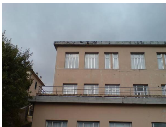
Figura 8.3 – Particolare della facciata esterna dell'edificio
