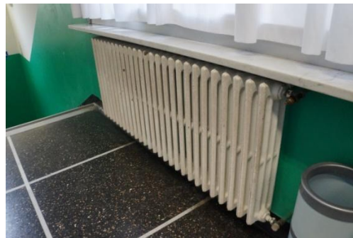
Figura 8.9 – Particolare terminali di emissione
